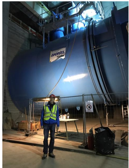
M. Benoît Sierro devant la conduite d'un diamètre de 6 mètres
