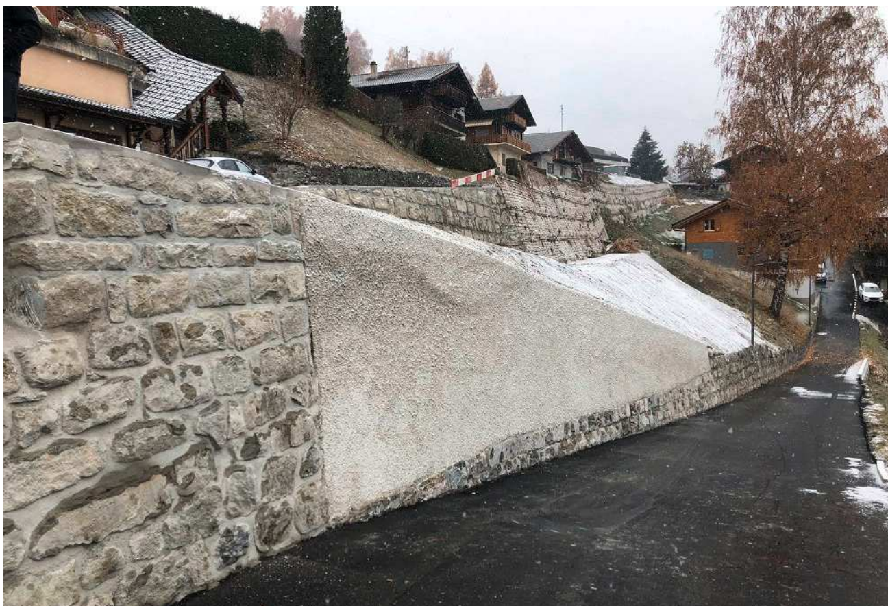
Travaux terminés, y compris les cheminements piétonniers
