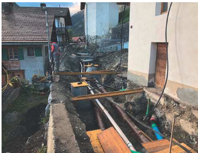
Fouilles dans la Rue Centrale
