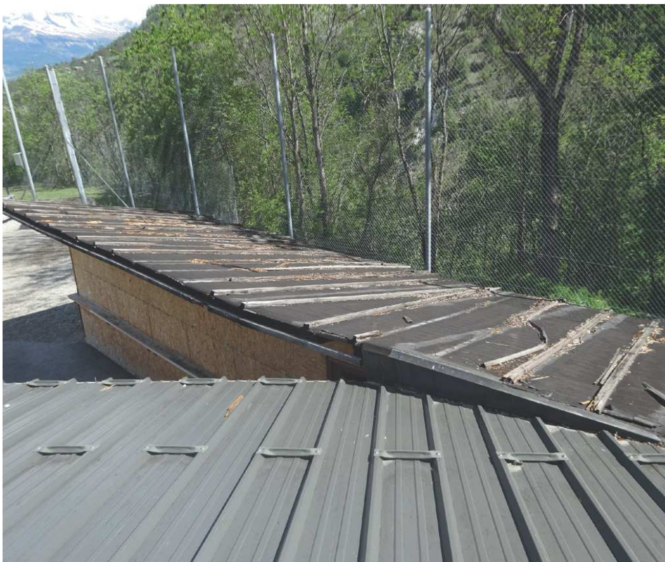
Etat de la toiture de la cantine à grillades avant les travaux
