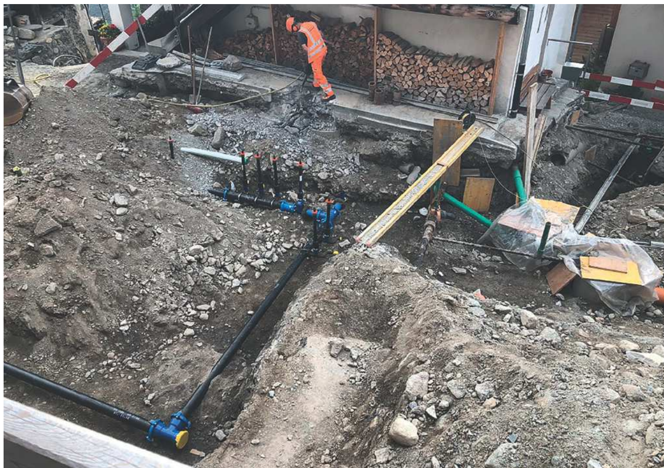
Construction du nouveau réseau d'eau potable dans la Place de la Fontaine
