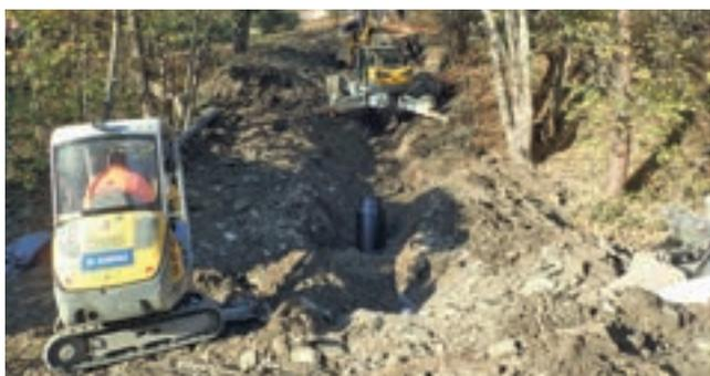
Les travaux se réalisent avec une pelle araignée en raison de la forte pente du tracé. Ils sont actuellement en pause hivernale et reprendront au printemps.
