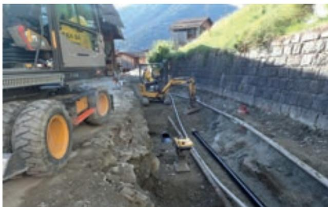
Un projet visant à mettre à neuf les services et à approfondir le tunnel a été élaboré. Les travaux ont débuté en montant, par la réfection des services et la reprise de la fondation de la route depuis les ateliers jusqu'à l'atelier de Genolet Promotions SA. Ils sont maintenant à l'arrêt pour la période hivernale et reprendront au printemps pour requalifier complètement ce tronçon jusqu'à l'écopoint de Pelette.
