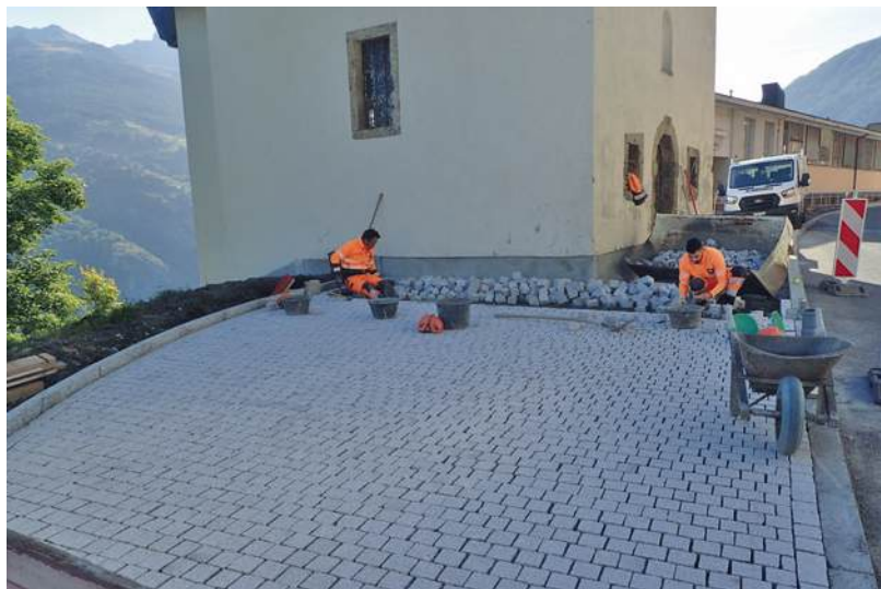
Pose des pavés devant la Chapelle St-Quentin
