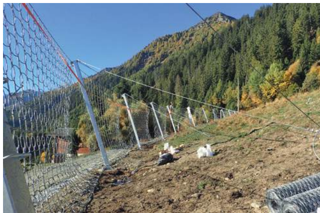
Montage des filets de protection
