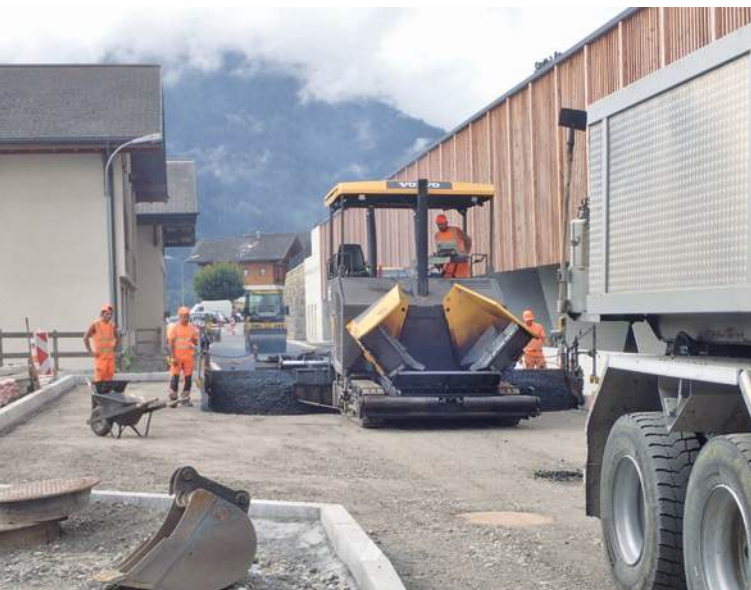
Pose de la couche de base des enrobés
