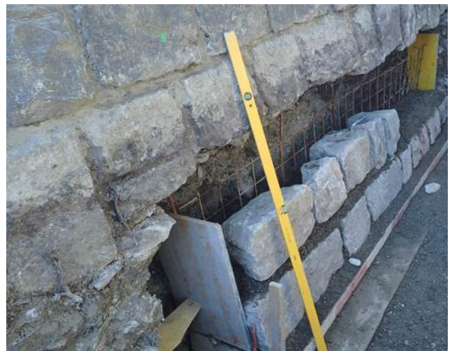
Reprise es sous-œuvre des murs
