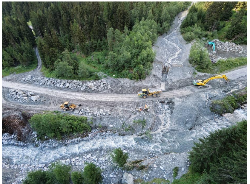
Situation pendant les travaux
